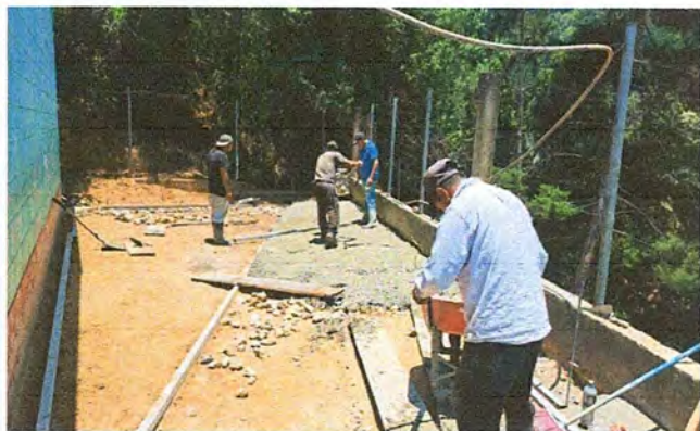
Foto 1: MEJORAMIENTO LOSA DE PATIO
